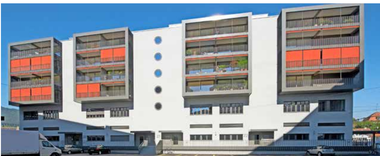
Viergeschossige Aufstockung SZU-Gebäude in Zürich (Bauherrschaft: Sihltal-Zürich-Uetliberg-Bahn SZU AG, Zürich; Architektur: Burkhalter Sumi Architekten, Zürich; Holzbauingenieur: Makio Wiederkehr AG, Beinwil am See).
