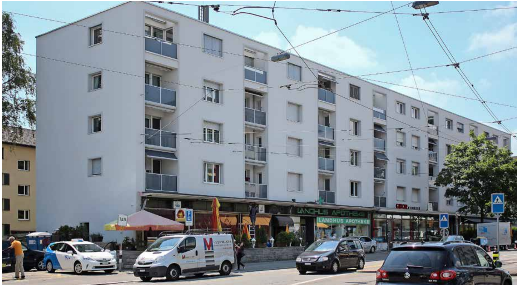
Aufstockung/Sanierung an der Schaffhauserstrasse in Zürich (Bauherrschaft: privat; Generalunternehmer: Häring Holz- und Systembau AG, Eiken).
